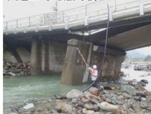
橋脚洗掘・沈下
