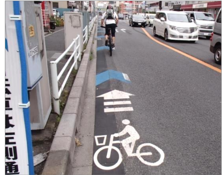
車道混在※（矢羽根型路面表示）
