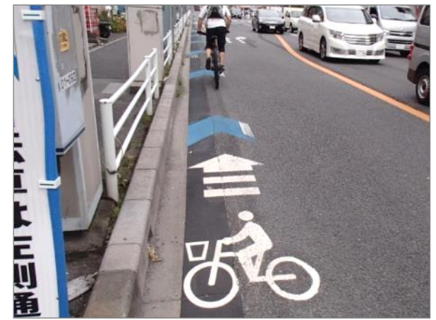
車道混在※ (矢羽根型路面表示)
