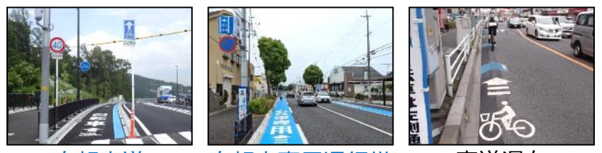
自転車道 自転車専用通行帯 車道混在 (矢羽根型路面表示)
