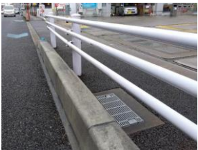
集水ますを歩道上に移設した事例
