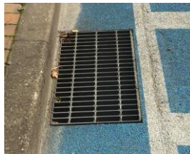
グレーチング蓋の格子の形状等を工夫した事例
