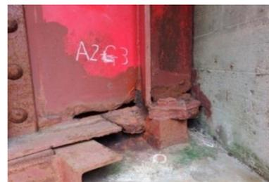
桁端部の腐食・貫通
