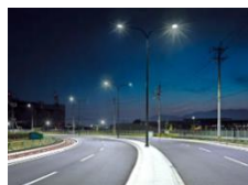
LED照明 (消費電力約56%削減)
