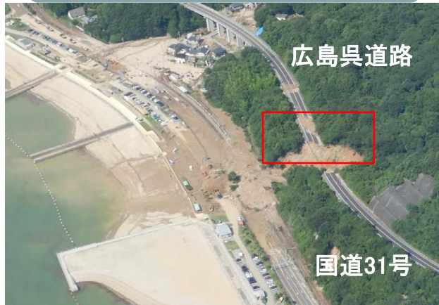
平成30年7月豪雨における 広島県道路の被災状況
