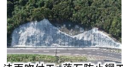
法面吹付工、落石防止網工
