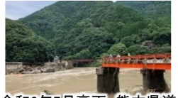
令和2年7月豪雨 熊本県道
