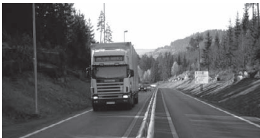
※ 6,000 台 / 日を超える交通需要がある路線は中央分離帯の設置が進められている。
