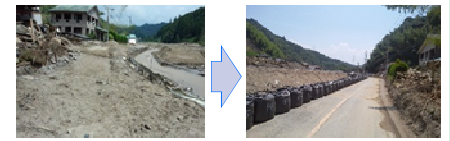
災害時の道路啓開
