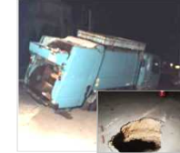
下水道の老朽化による道路陥没
