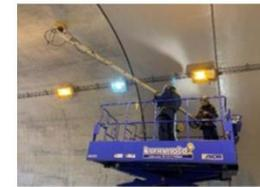
レーダーを利用したトンネル覆工の損傷把握
