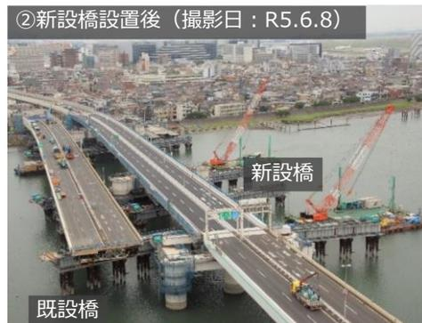
延長約300mの新設橋を既設橋の位置へ移動して架設
