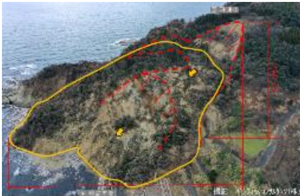
地すべり・斜面崩壊(逢坂トンネル坑口埋没)
