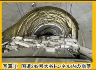
写真① 国道249号大谷トンネル内の崩落
