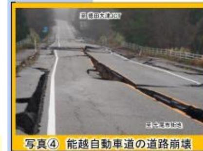
写真④ 能越自動車道の道路崩壊
