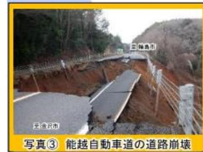
写真③ 能越自動車道の道路崩壊
