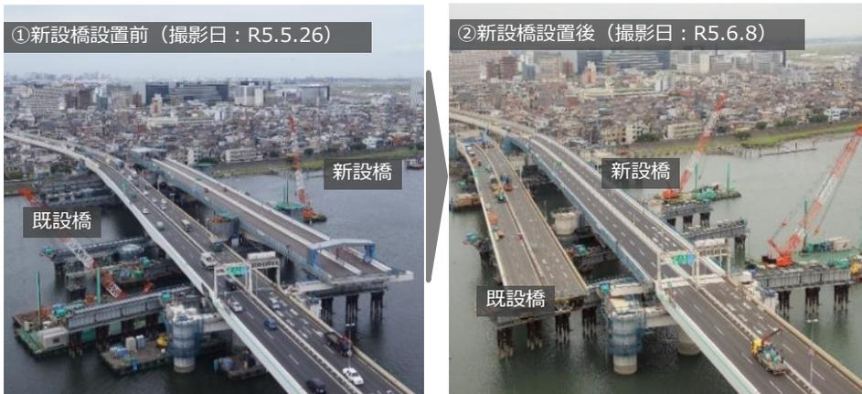
延長約300mの新設橋を既設橋の位置へ移動して架設
