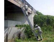
新技術活用点検（「ひびわれの自動検出」と「ひびわれ幅の自動計測」をAIを活用し損傷図作成）
