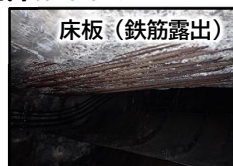
< 損傷状況・維持作業状況 >
