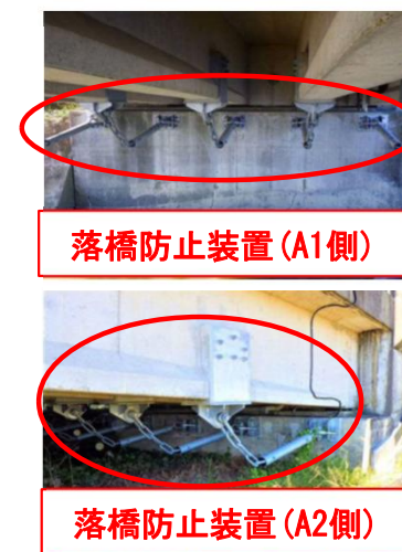
〈施工完了（拡大）〉
