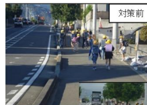
防護柵の設置
