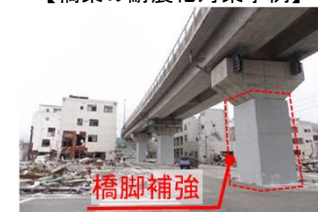
橋脚補強 耐震補強例（釜石高架橋）
