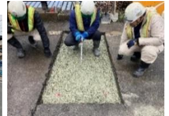
空洞補修工事
