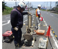
(貫入試験による調査)
