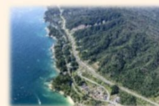
三陸沿岸道路 (岩手県山田町)
