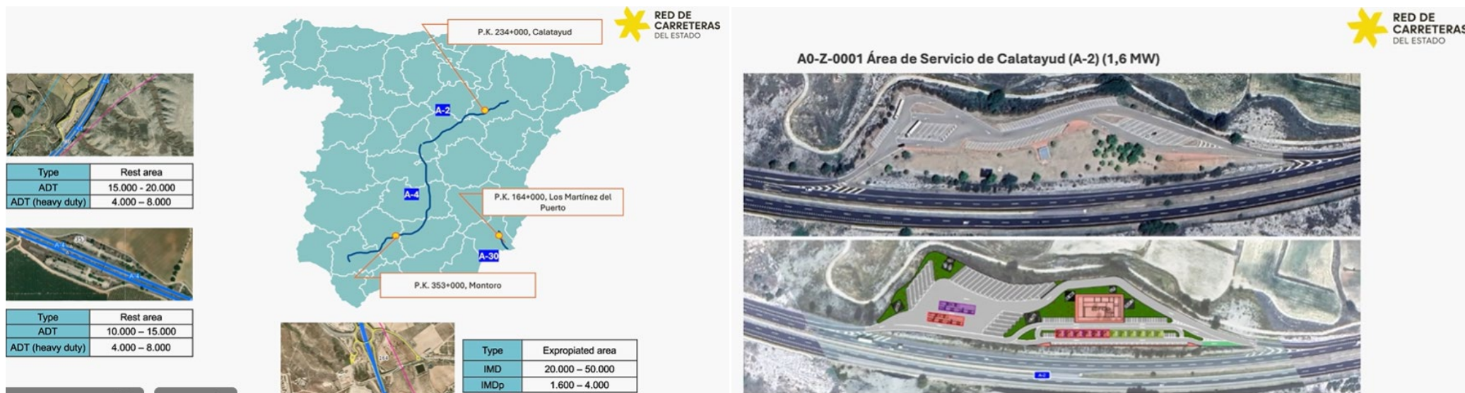
スペイン SA・PAの拡張工事・給電器の設置工事の様子
